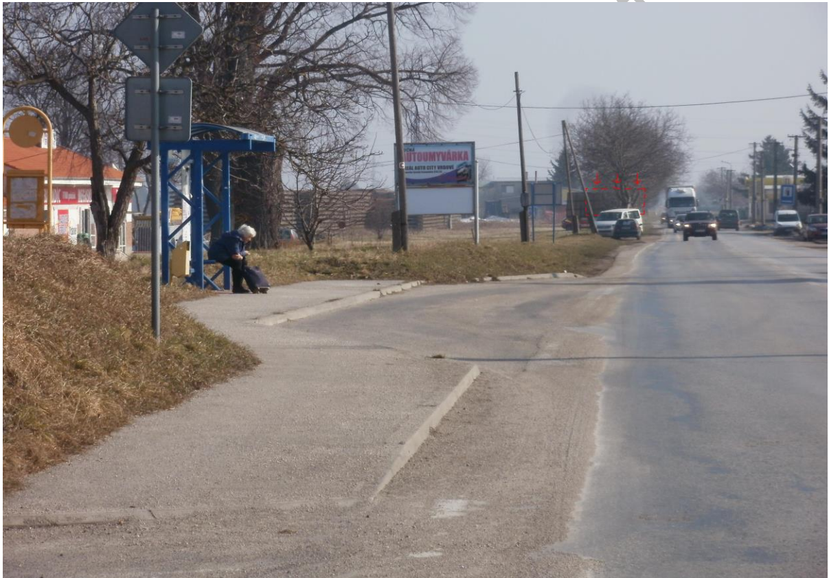
Piešťanská cesta II/499, lokalita oproti ČS PH, skladová zóna
